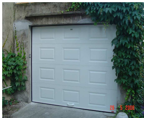
Porte de garage sectionnelle avec isolation 42mm, manuelle ou électrique ou simple levante en plafond ou battante
