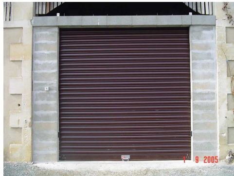
Rideau métallique galva ou peint, manuel ou électrique et automatisé, ne prend que 35cm en partie haute intérieure
