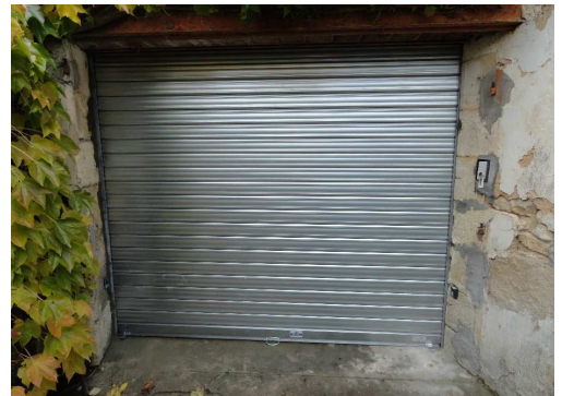
Rideau métallique galva ou peint, manuel ou électrique et automatisé, ne prend que 35cm en partie haute intérieure
