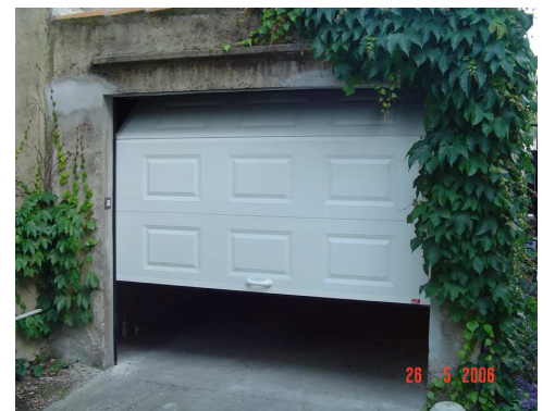
Porte de garage sectionnelle avec isolation 42mm, manuelle ou électrique ou simple levante en plafond ou battante
