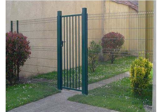
clôtures panneaux rigides, portillon avec ses poteaux ferrés
